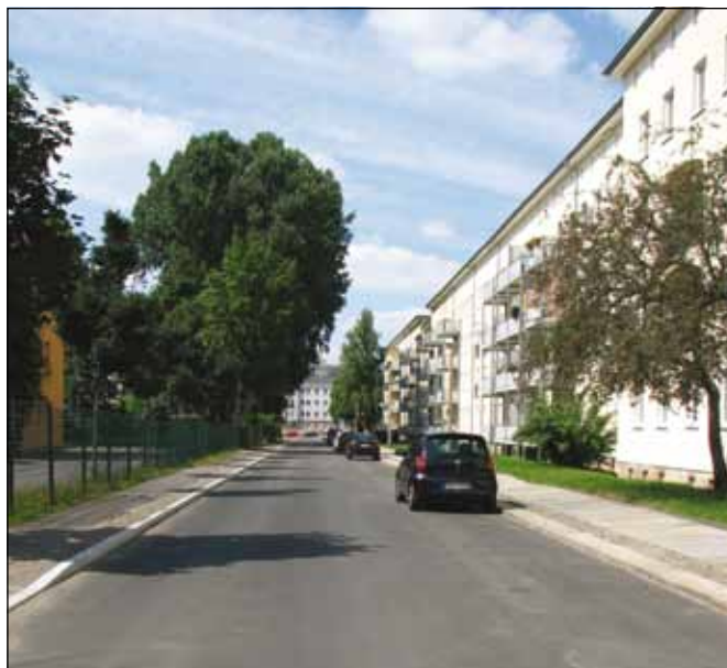
Gut geworden: Das Tiefbauamt hat die Brauhausstraße zwischen Clara-Zetkin-Straße und Annenstraße instandgesetzt, auch die Wiesenstraße, über die der Radverkehr umgeleitet wird, ist saniert.
