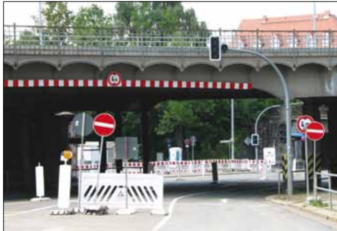
Der Kreuzungspunkt Altchemnitzer Straße/Reichenhainer Straße wird zukünftig durch einen Kreisverkehr ersetzt.
