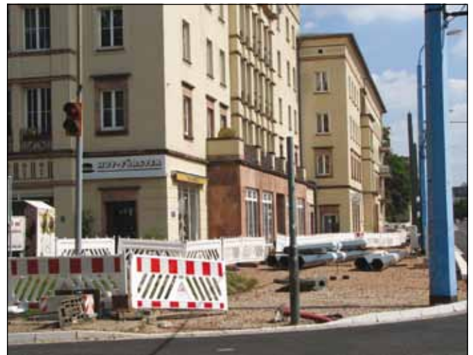
Viel Geduld ist von den Anliegern gefordert, weil Gehwege schon seit Monaten unpassierbar sind.
