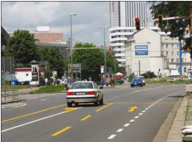
Bauarbeiten und in ihrem Gefolge Straßensperrungen und Umleitungen, wohin man schaut: Zschopauer Straße, Reitbahnstraße, Annenstraße und Annaberger Straße sind betroffen. Zur Reitbahnstraße lesen Sie mehr auf Seite 2.
