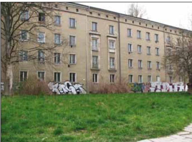
Die unsanierten Häuser Fritz-Reuter-Straße 25-29 sind ein Schandfleck im Stadtteil und stören die Bewohner gewaltig. Leider ist keine Lösung in Sicht.
