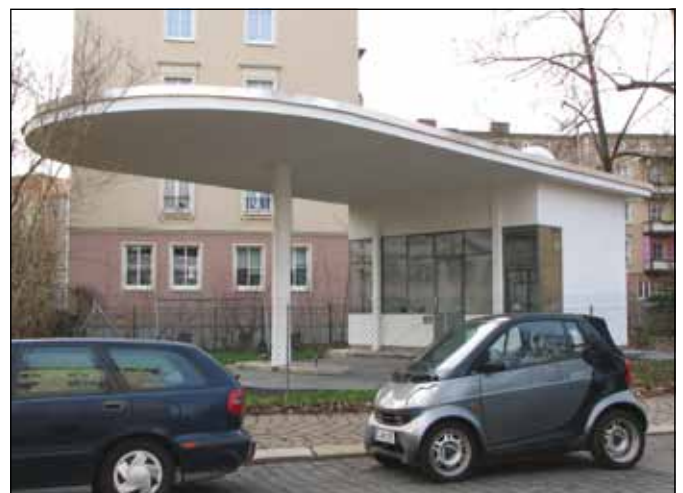
Mit EFRE-Mitteln wurden im Zeitraum von 2009 bis 2014 viele kleine Unternehmen im Gebiet gefördert. Darunter auch der Umbau der alten Tankstelle an der Annenstraße zum kleinsten Hotel der Welt. Durch das Hochwasser im Juni 2013 wurde das Objekt schwer beschädigt und deshalb später als geplant fertiggestellt.
