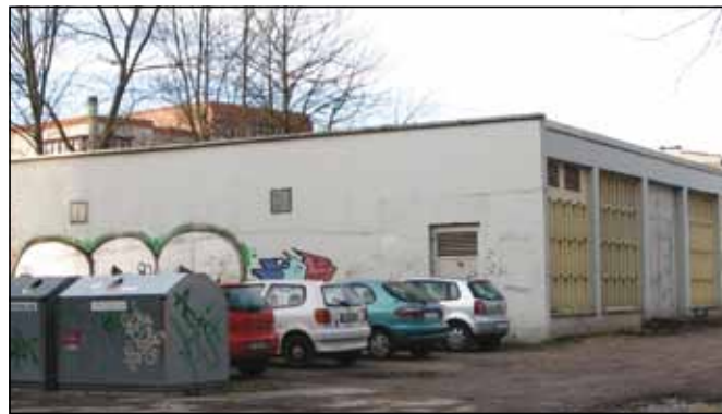
Die Fernwärmestation an der Karl-Immermann-Straße soll in diesem Jahr zurückgebaut werden.
