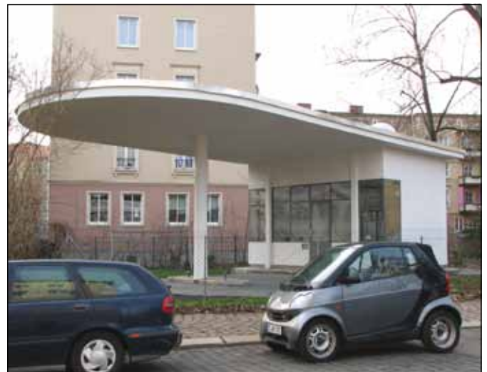
Die alte Tankstelle an der Annenstraße wurde mit einiger Verzögerung zum kleinsten Hotel der Welt. Noch ist es nicht gelungen, einen Blick ins Innere zu erhaschen - wir bleiben dran.
