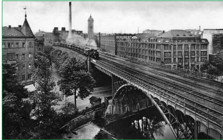
Historische Ansicht vom Chemnitztalviadukt.
