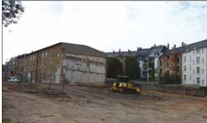
Die Industriebrache an der Uferstraße 8, ehemals Hunger Hydraulik, wurde abgerissen. Die Fläche soll im Frühjahr begrünt werden.
