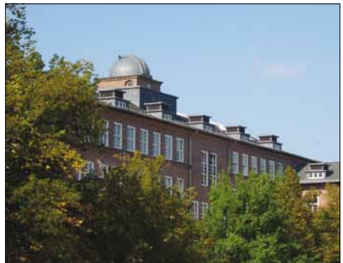
Das Agricola-Gymnasium erhält eine Photovoltaikanlage.
