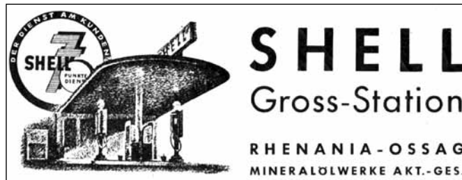
Die Tankstelle an der Annenstraße führte Benzin von Shell, damals eine Marke der Rhenania-Ossag Mineralölwerke AG. Abbildung: Sammlung Fassmann
