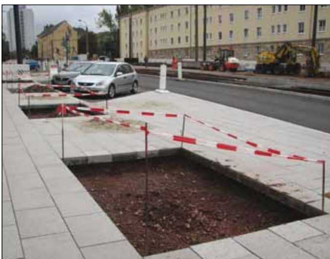
Auf der stadtwärtigen Fahrbahn rollt der Verkehr wieder. Platten werden verlegt und Baumgruben ausgehoben.
