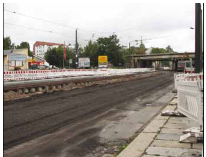
Vorm Residenz-Hotel wurde die Fahrdecke aufgefräst, um eine Trinkwasserleitung und einen Abwasserkanal zu verlegen.
